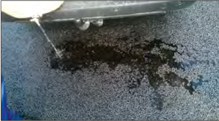
Figure 6 - Test de drainabilité sur le chantier de la RD 948 - BBDr 0/10 classe 1
