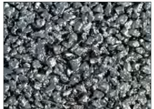
Figure 2 - Texture d'un enrobé drainant après compactage
