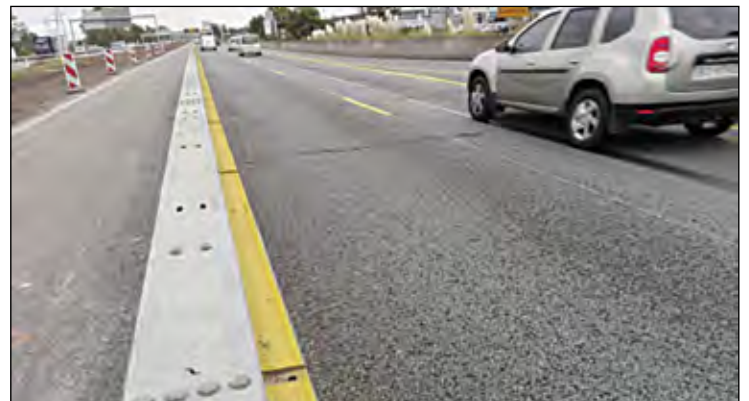
Figure 7 - BBDr après 25 ans d'exploitation - Rocade de Bordeaux
