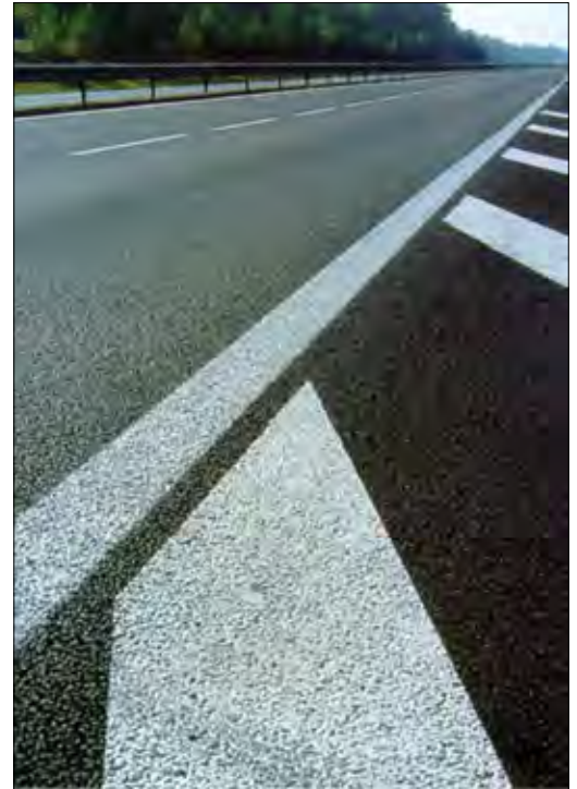
Figure 1 - Chantier de BBDr sur autoroute avant ouverture au trafic
