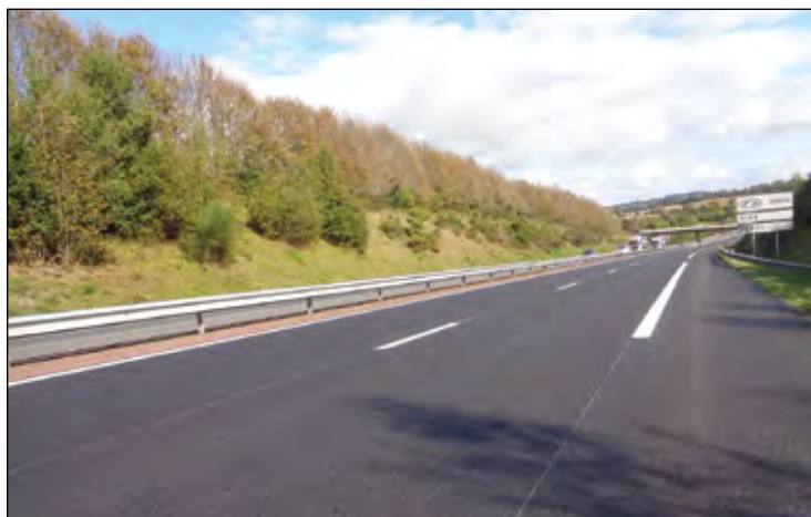
Figure 4 - BBDr 0/10 mis en œuvre en septembre 2017
