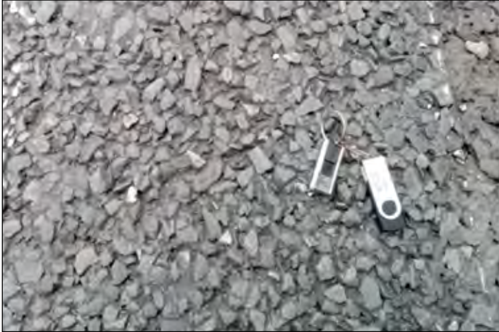
Figure 8 - BBDr colmaté après 27 ans, mais reste rugueux avec assez peu d'arrachement eu égard à la forte porosité de départ - Rocade de Bordeaux
